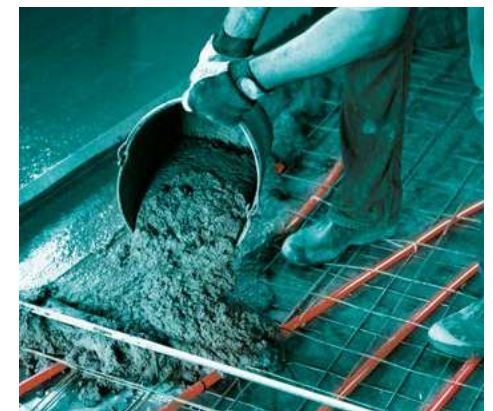
RISCALDAMENTO A PAVIMENTO
