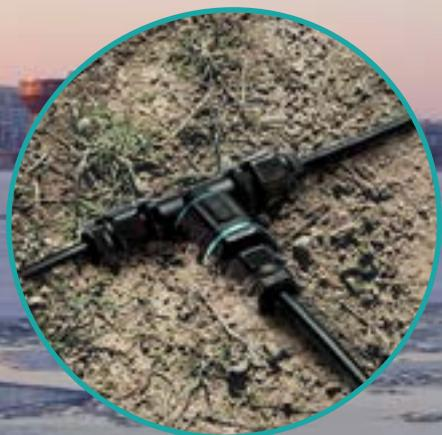
Il posizionamento del connettore direttamente a contatto con il terreno non è sempre possibile. E' buona norma collocare il connettore in pozzetti o vani dedicati a contenere componenti di installazione e al cablaggio dei cavi. L'installazione deve essere accessibile e facilmente visibile per effettuare l'ispezione e garantirne la manutenzione.
