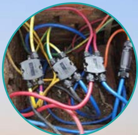
È importante effettuare una corretta chiusura dei connettori per evitare un eccessivo stress meccanico nell'accoppiamento. Ripiegamenti dei cavi o flessioni troppo acute nei pressi del pressacavo generano stress sui componenti, compromettendone il funzionamento.
