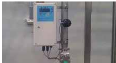
Connessione pannello di controllo impianto di imbottigliamento (Australia). Serie TH387.
