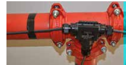
Connessione di cavi scaldanti (Italia). Serie TH211.
