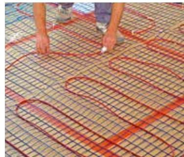
Giunzione di cavi scaldanti.
